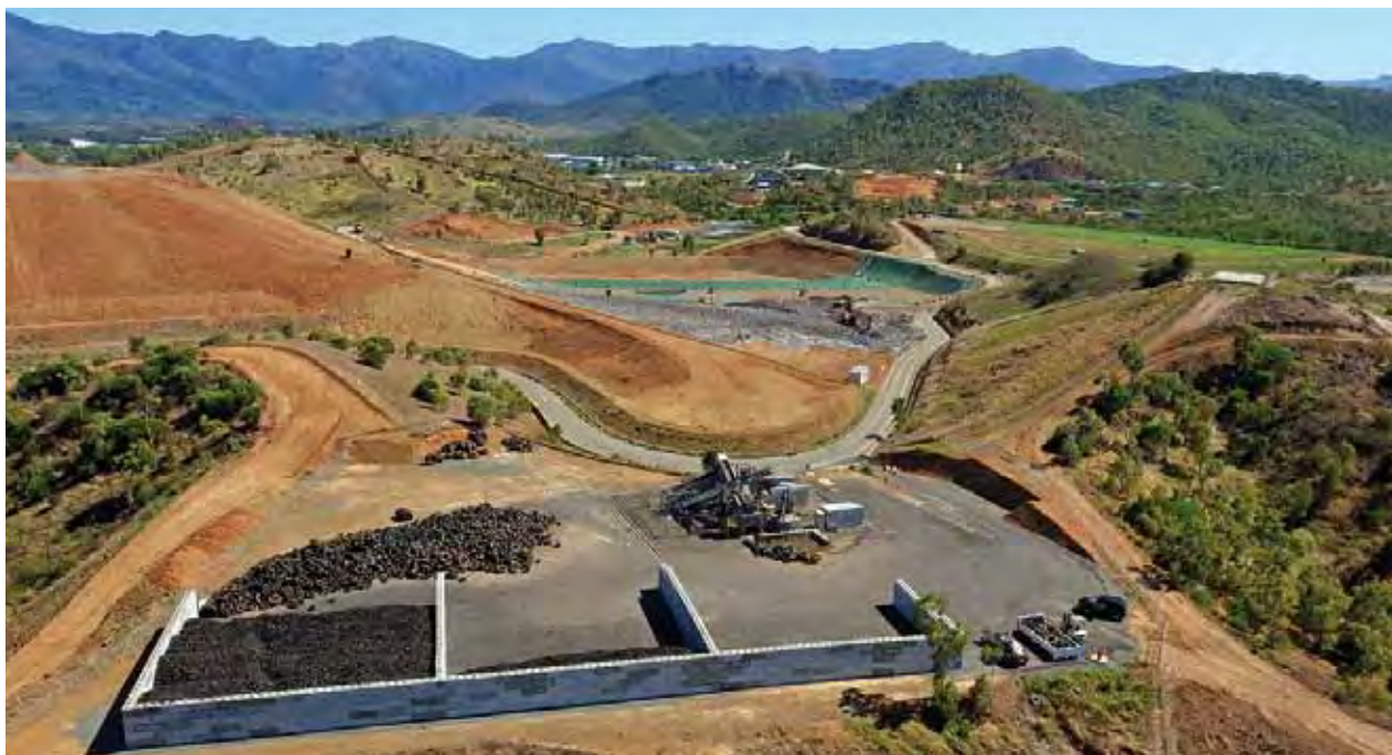
Une Installation de Stockage des Déchets Non Dangereux (ISDND) répond à des normes strictes afin d'éviter toute percolation des « jus » des déchets dans la nature.
